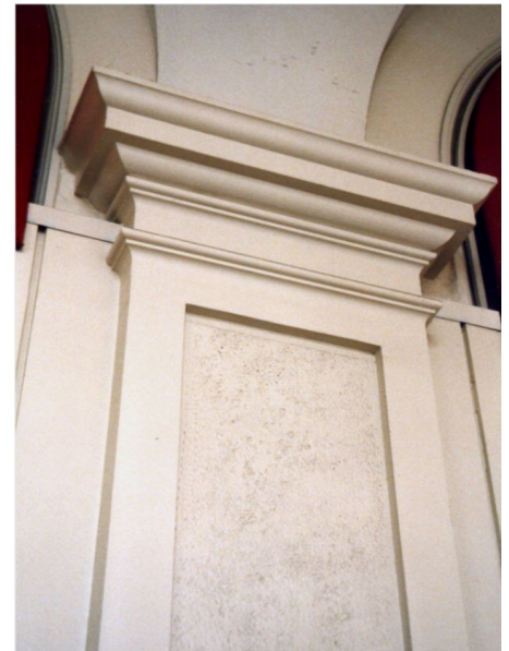
Detail einer Stützenverkleidung auf einer Fassade aus Acrystal Prima - Laminiert mit 200-4D Faser in ca. 7mm Stärke
