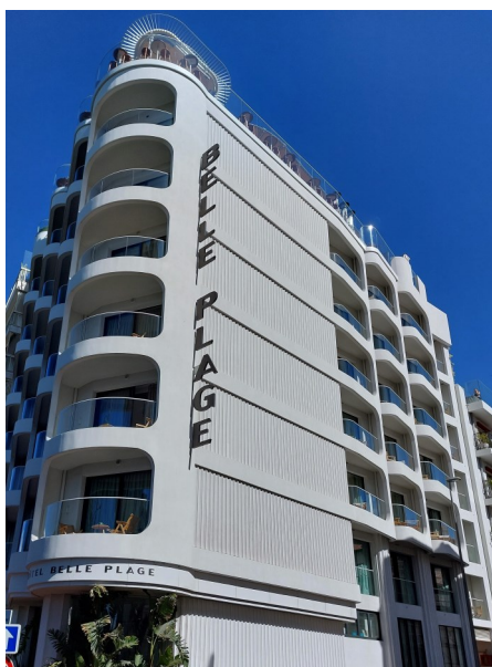
Fassade des Belle Plage Hotels in Cannes – Wellplatten mit geriebener Beschichtung – Planet Staff – Cagnes sur Mer – Atelier Jean- Loup Bouvier – Les Angles
